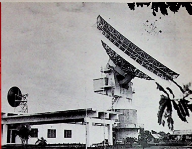
Afb. 1. De paraboolantenne van het nieuwe Intelsat-grondstation in Djatiluhur op Java heeft een diameter van 27 m. Via een straalverbinding van 100 km lengte is het station met Bandoeng en Djakarta verbonden.
